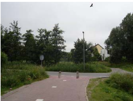
onduidelijke aansluitingen oost-west (Veldpad)
